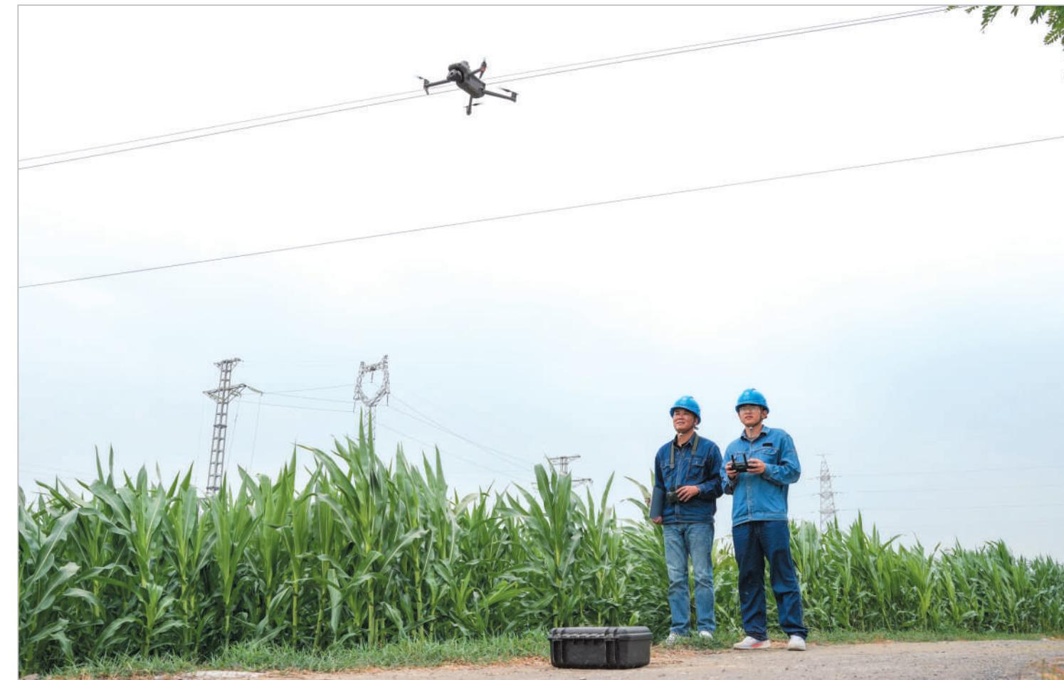
8月1日，国网濉溪县供电公司工作人员利用无人机、红外测温仪，对供电线路进行全面巡检，重点保障居民生产生活用电及煤炭能源运输供电安全。
