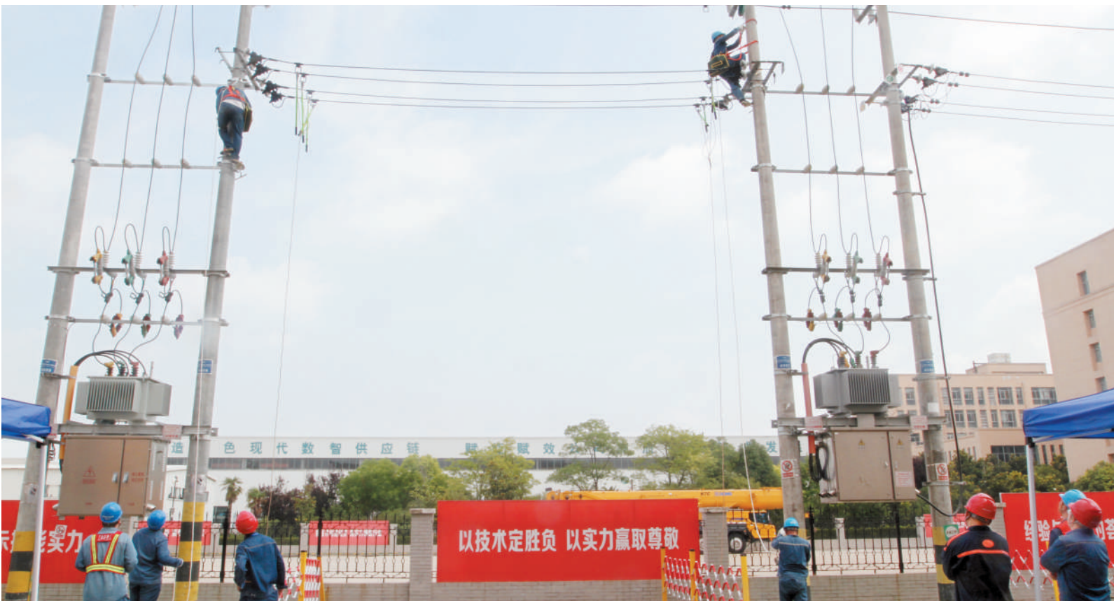
6月27日，国网淮北供电公司组织开展配网安全技能竞赛，检验配网运检和配网抢修岗位员工在配网运检和抢修过程中对安全工器具的执行情况，和登高挂接地线等安全技术能力，锻炼配网抢修作业明白人。该公司20支代表队参加。
