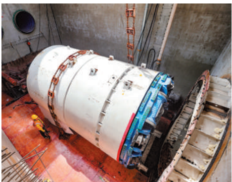
淮北市城乡地表水厂取水泵站及配套管网项目迎来关键节点——输水隧洞盾构机“康泉一号”机头在始发井顺利完成吊装下井，为盾构正式掘进奠定坚实基础。
