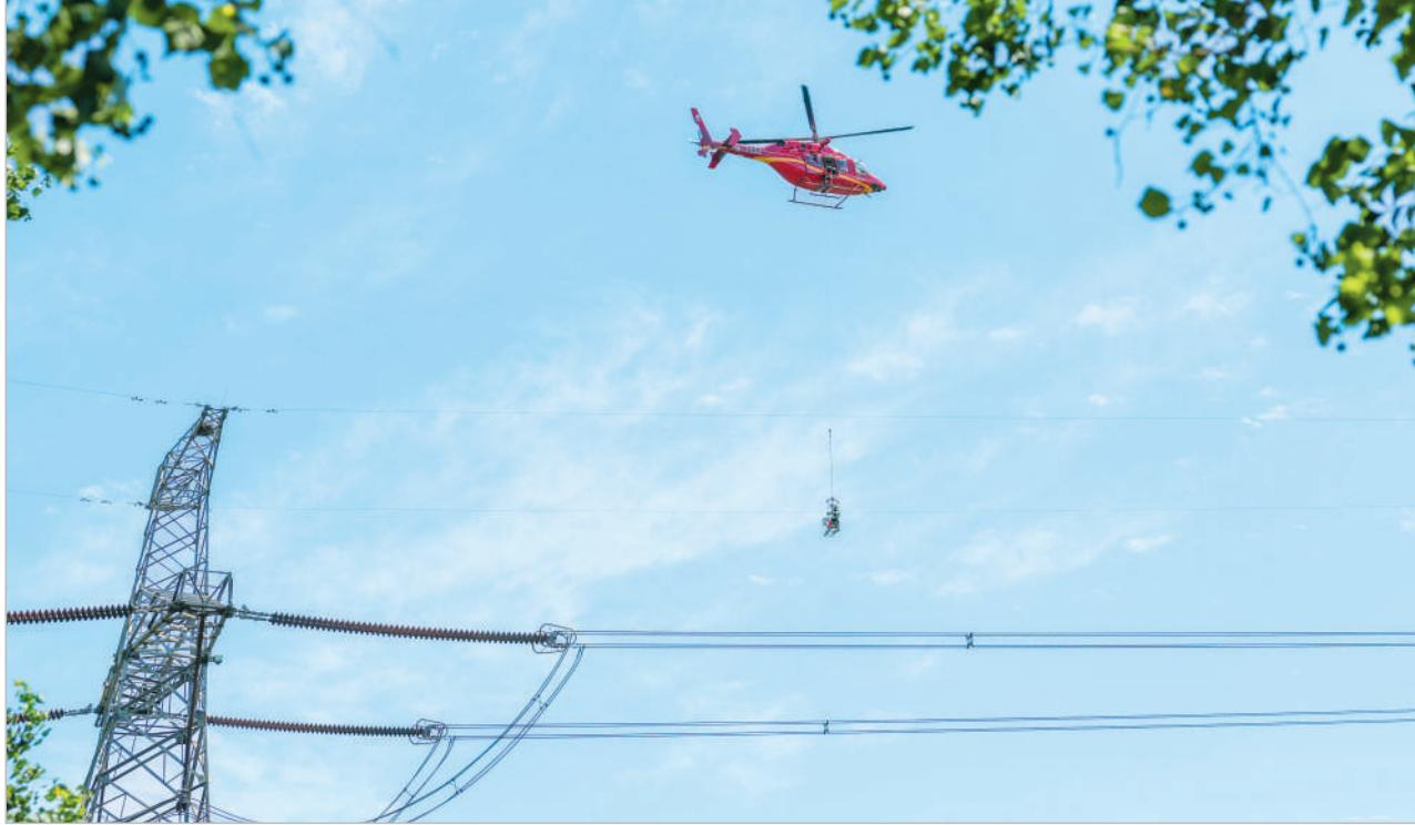
7月24日，在浙江湖州市长兴县吕骨线附近，一架直升机运送带电作业人员至超特高压线路检修点作业。
