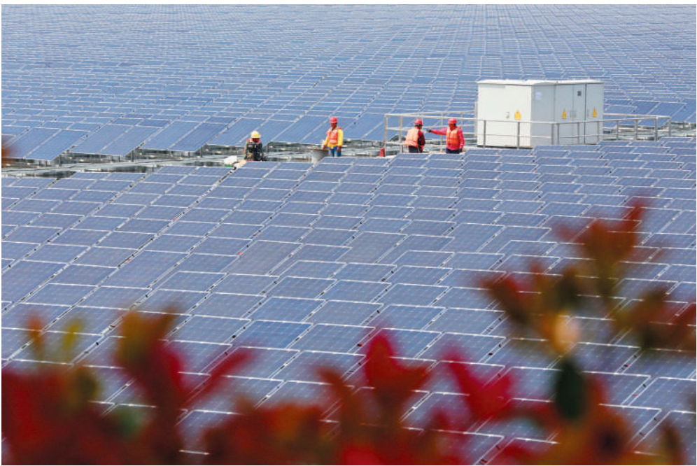
我市利用采煤沉陷区水面建起漂浮式光伏发电站。 ■ 摄影 记者 万善朝
