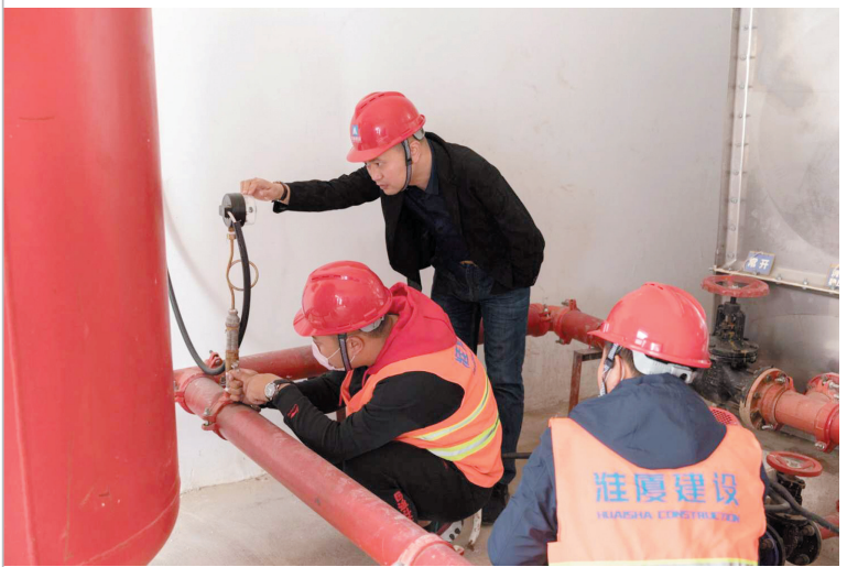
刘忠明和员工在消防工程施工现场调试消防联动。
