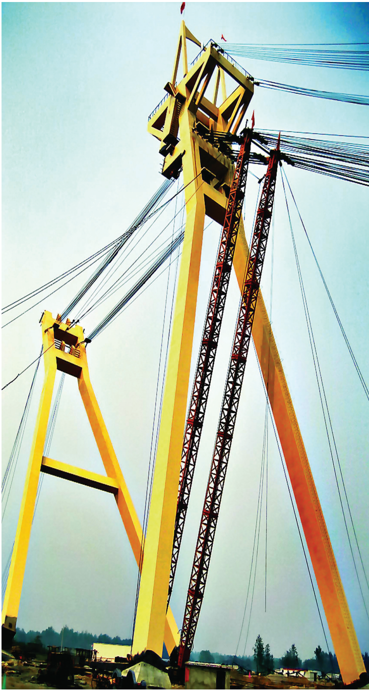
集团吊装的国投新集集团孜东煤矿主井井架，为当时世界第一大钢结构井架。
