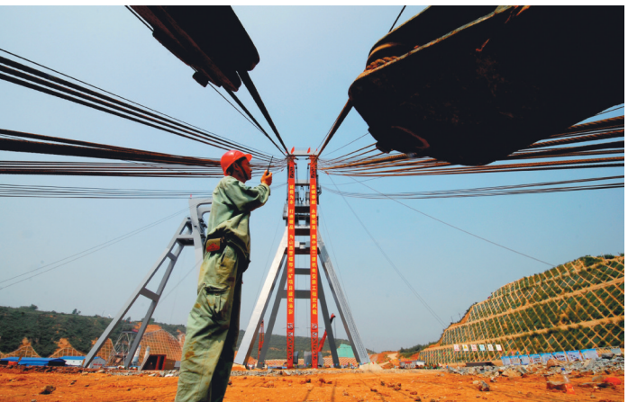
集团吊装的世界最大的副井井架——山西晋城郑庄煤矿副井井架。
