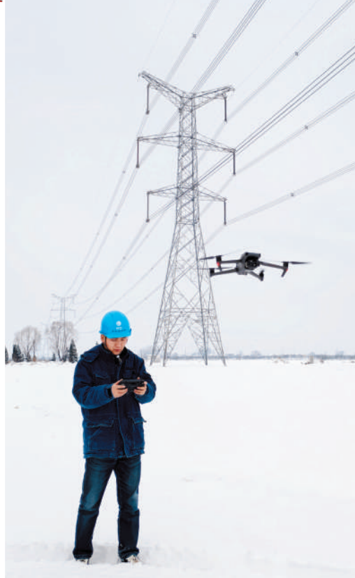
无人机巡检和线路通道排查。
