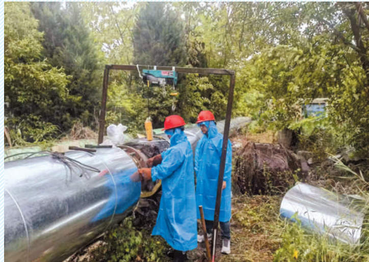
工作人员利用雨歇间隙抓紧施工,确保能源稳定供应。
