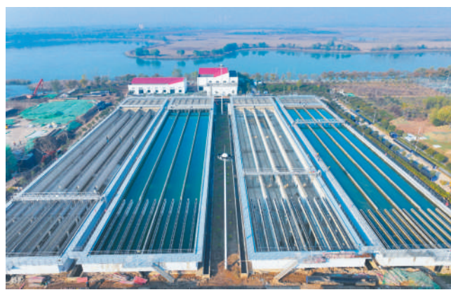
水厂正在对沉淀池等各类设施、设备进行调试。
