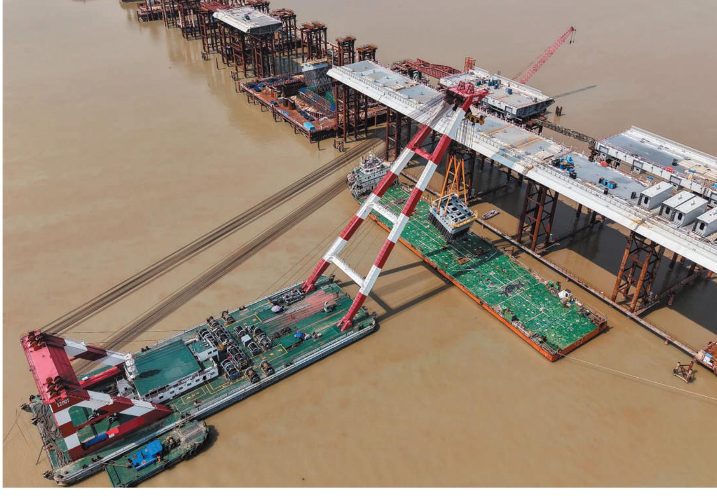
10月10日，浮吊船在珠江口吊起万龙大桥主塔首节段钢塔(无人机照片)。
