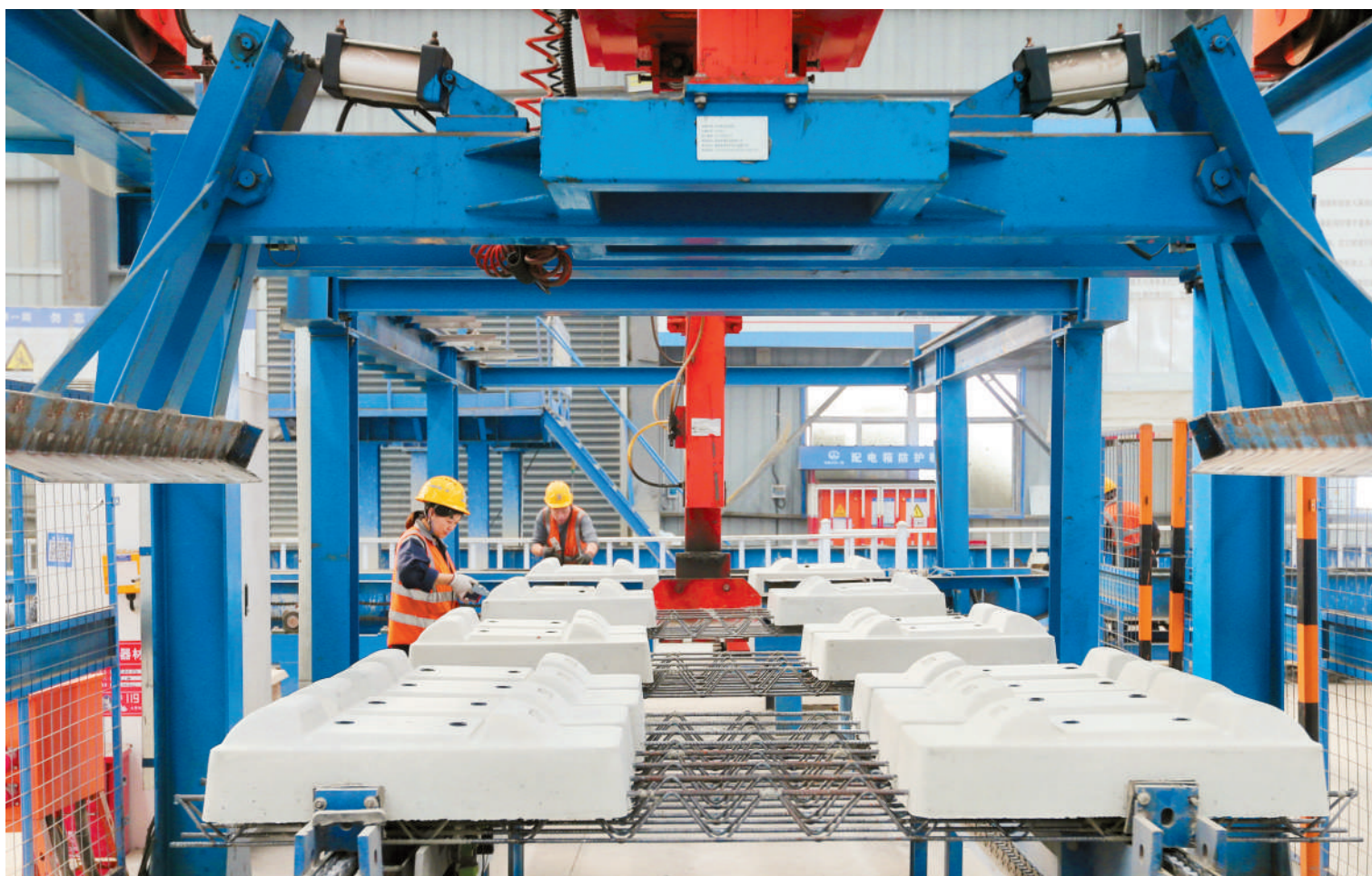
淮宿蚌城际铁路 轨枕预制忙
