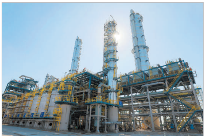
碳鑫科技二期甲醇综合利用项目。
