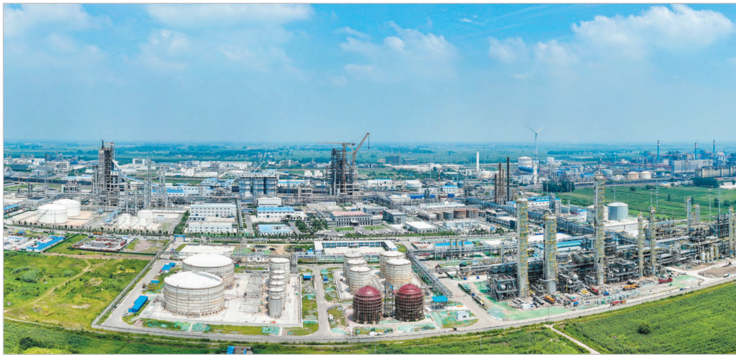
碳鑫科技二期甲醇综合利用项目全景。
