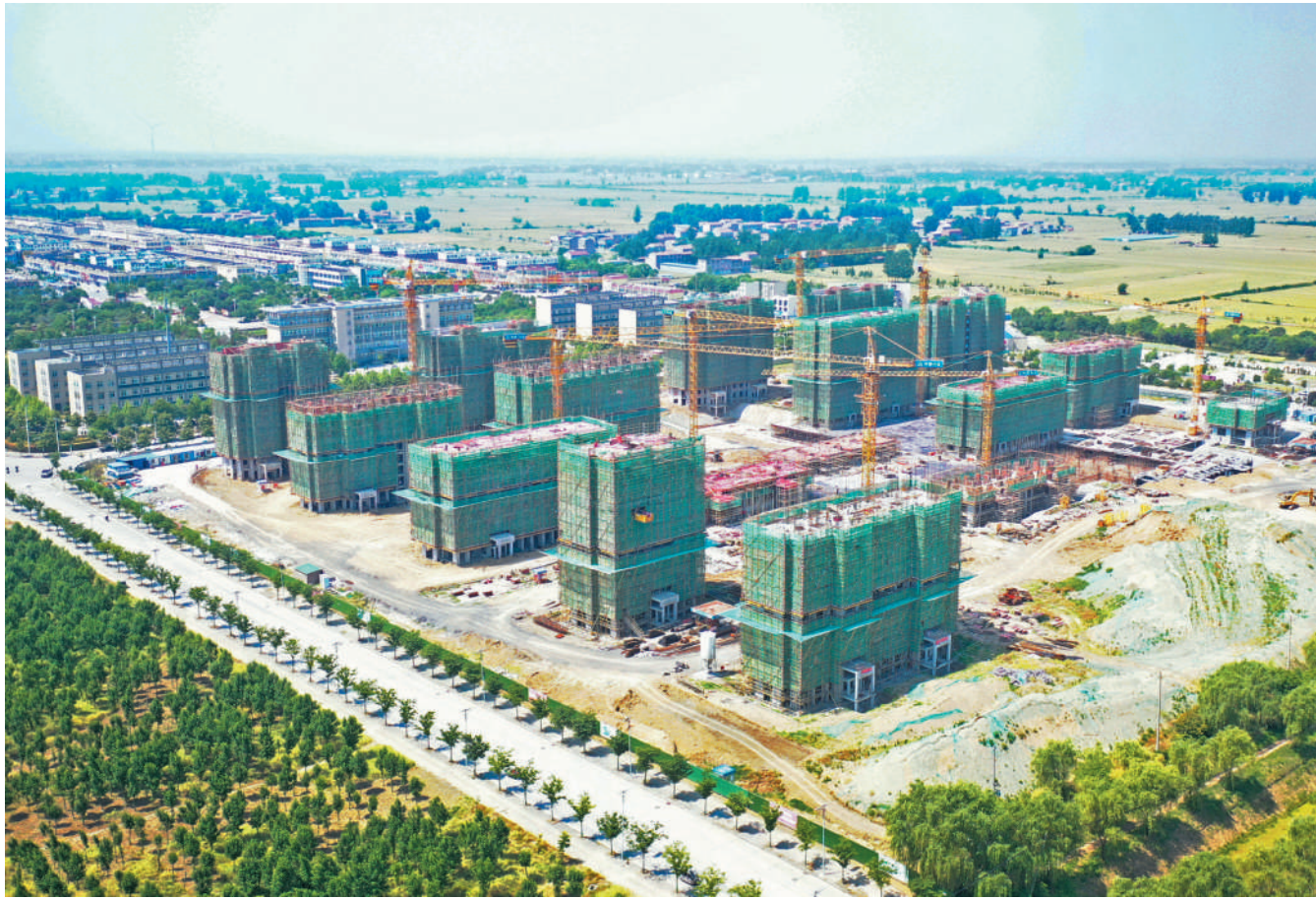
五沟镇界沟矿安置房建设加快推进。
