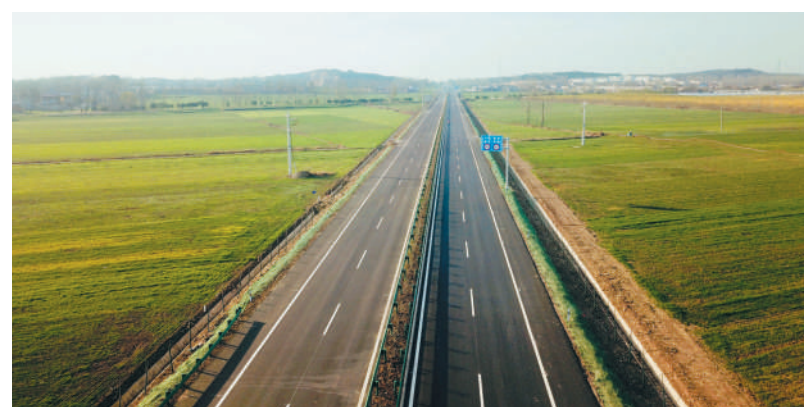
S101合相路(二期)及S254古毛路改建工程项目
