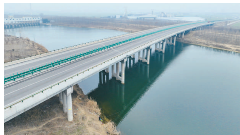
S235淮唐路改建工程
