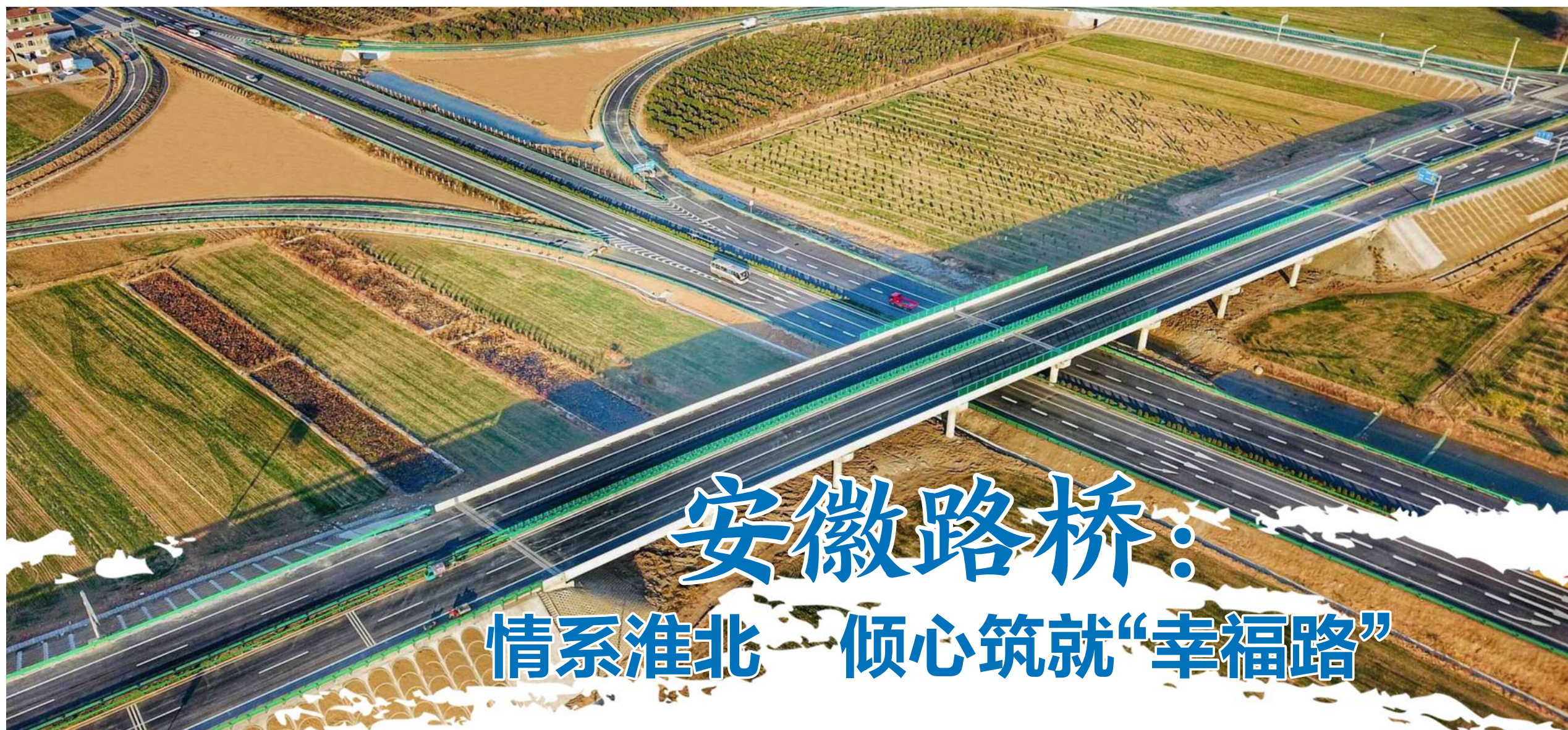
S101合相路(二期)及S254古毛路改建工程项目
