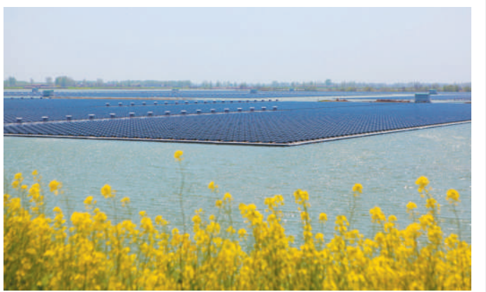
南坪镇依托沉陷水面建成光伏发电项目。
