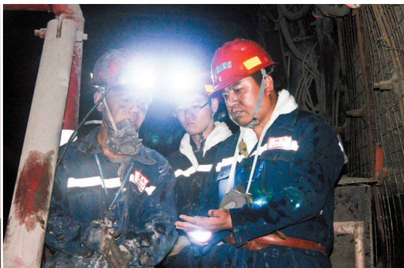
朱昊（右一）在井下检查设备检修情况。
