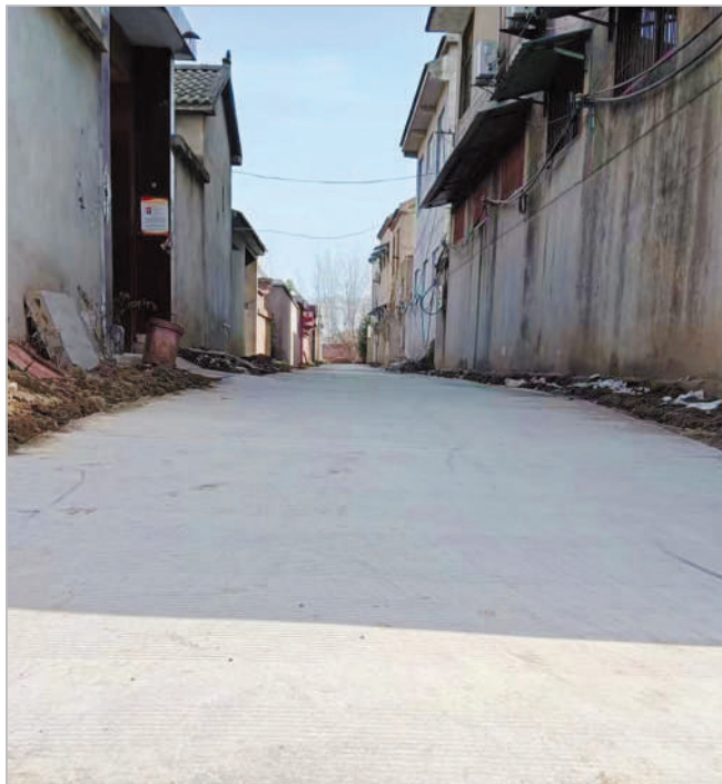
巷道由泥土路变身水泥路。
