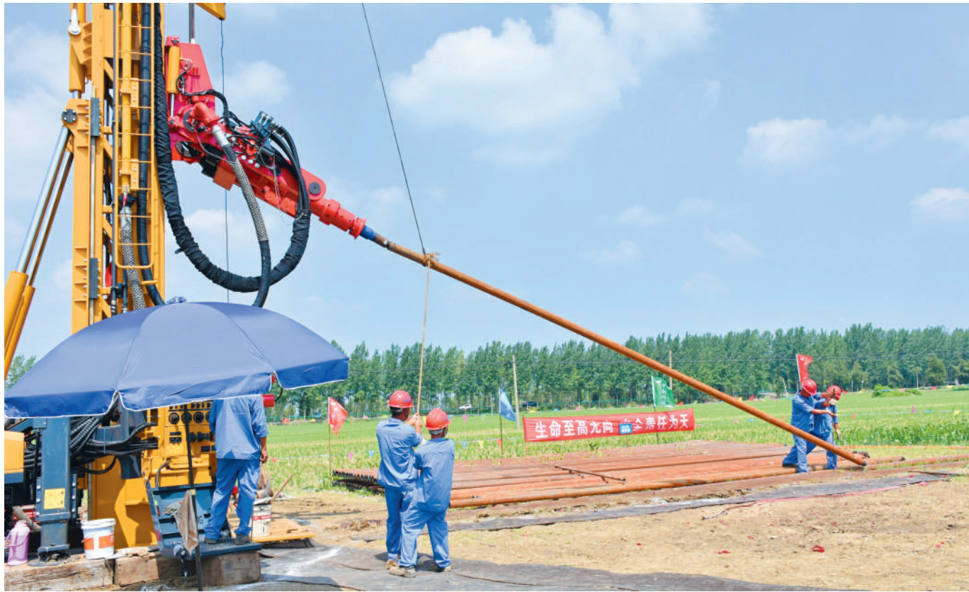
地勘工程现场汽车钻安加尺下钻。
