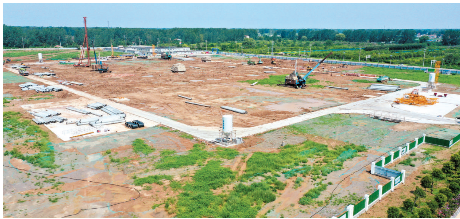
7月12日,淮北翌光科技OLED产业化项目施工现场。 摄影 记者 万善朝
