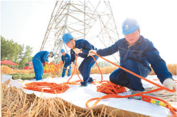
工人进行高空全线登塔走线检查前的准备工作,以确保高空带电作业的安全。
