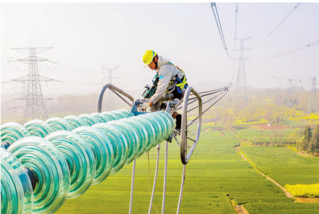
高空检修特高压直流输电线路。
