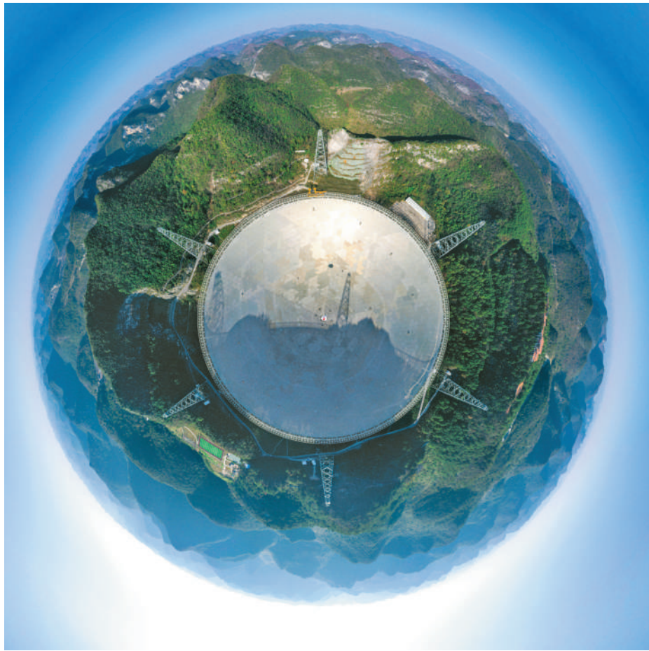
2021年12月19日拍摄的“中国天眼”全景(维护保养期间摄,无人机照片)。
