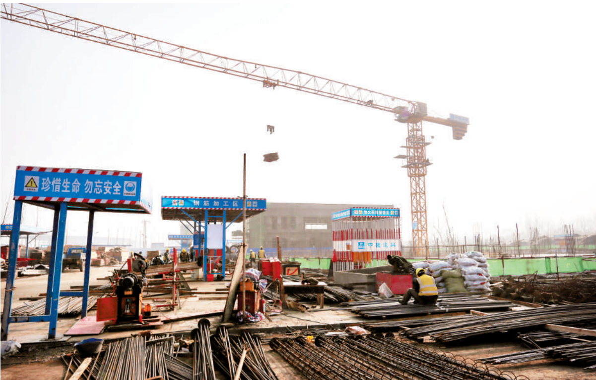
中德产业园标准化厂房项目桩基施工。
