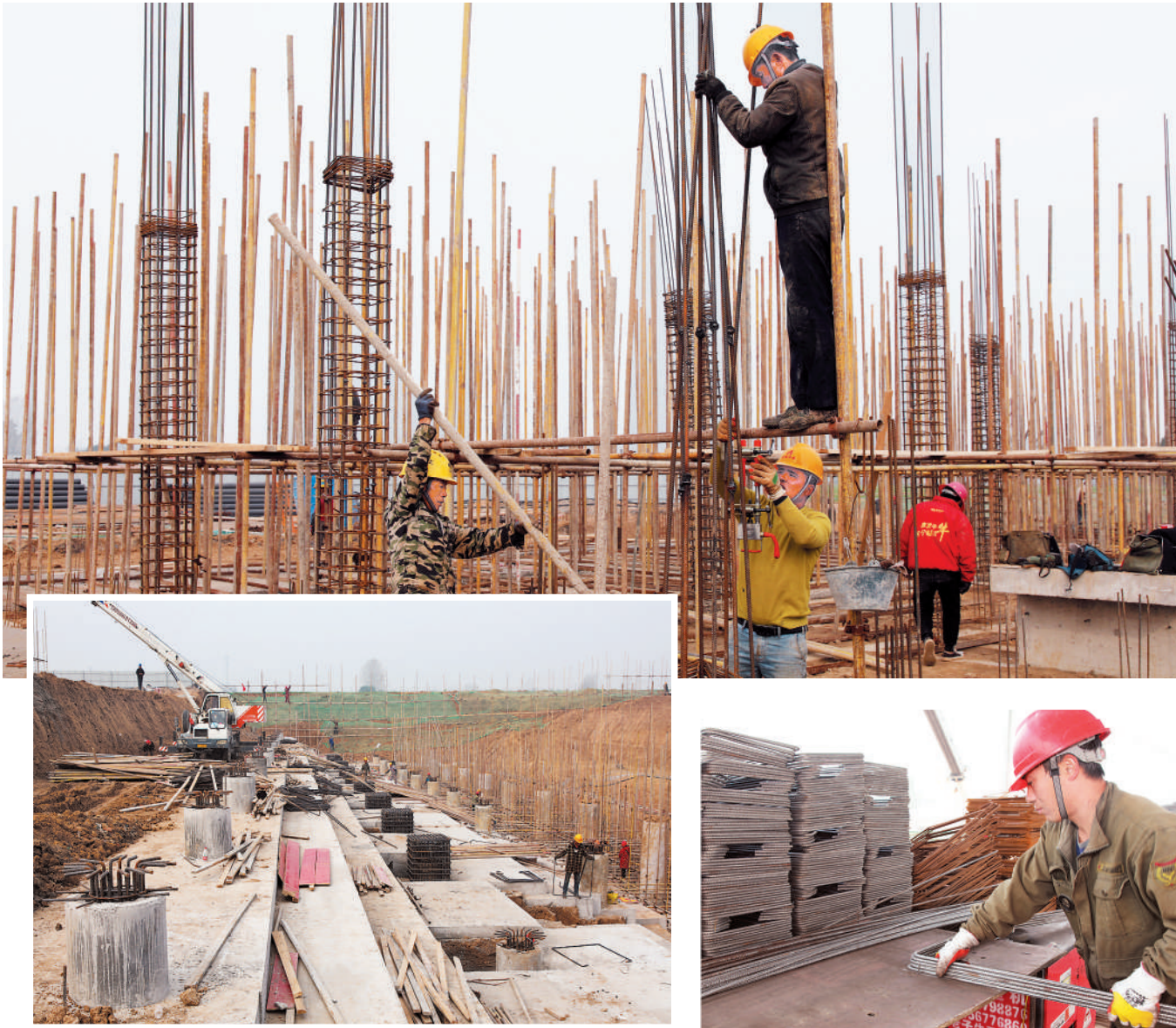
图为热火朝天的淮北港孙疃码头工程施工现场。
