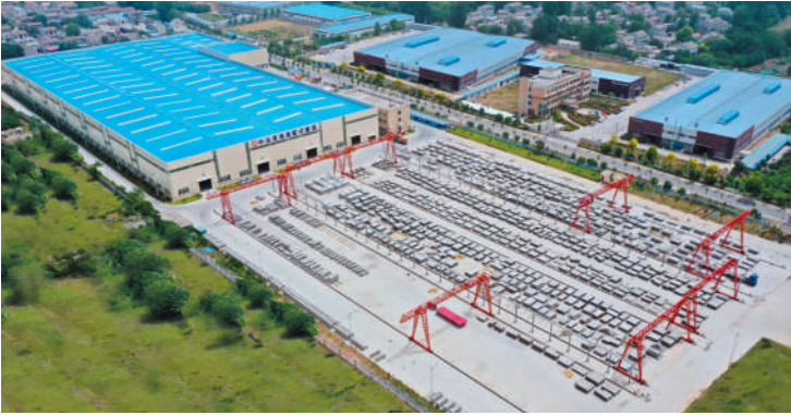
中冶淮海公司预制构件生产车间
