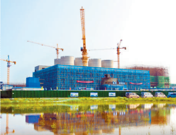
相山水泥绿色示范线建设
