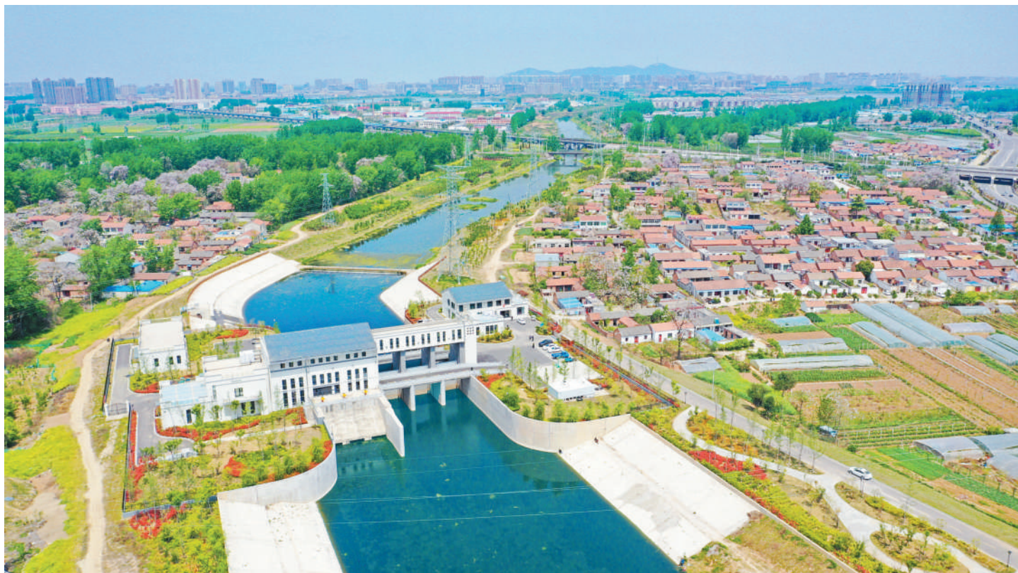
老滩河城市防洪排涝工程。摄影 记者 冯树凤
