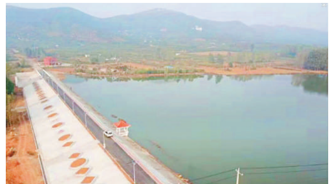
八里岗水库除险加固工程。摄影 记者 冯树凤
