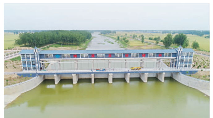
新沱河徐楼闸除险加固工程。摄影 记者 冯树凤
