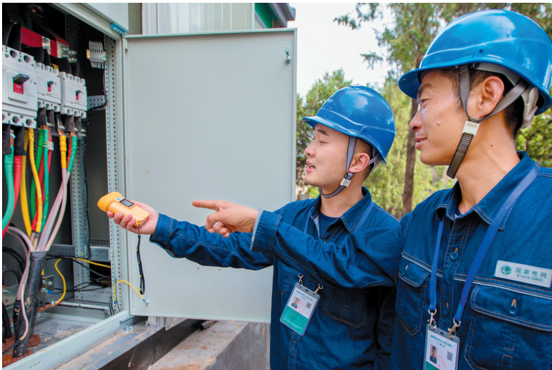
施工人员正在进行电缆终端红外温度检测。 ■ 摄影 通讯员 赵珊珊
