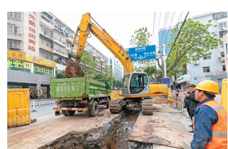
淮北市雨污分流工程范围共计47.4平方公里,划分为西部片区、相阳沟片区、老城片区、东部片区4个区域。工程包括市政道路污水管网39条,共计长度约35公里,需要雨污分流改造的小区及企事业单位共计361个,新建、改建污水泵站5座,工程预估总投资12亿元,计划总工期为5年。
