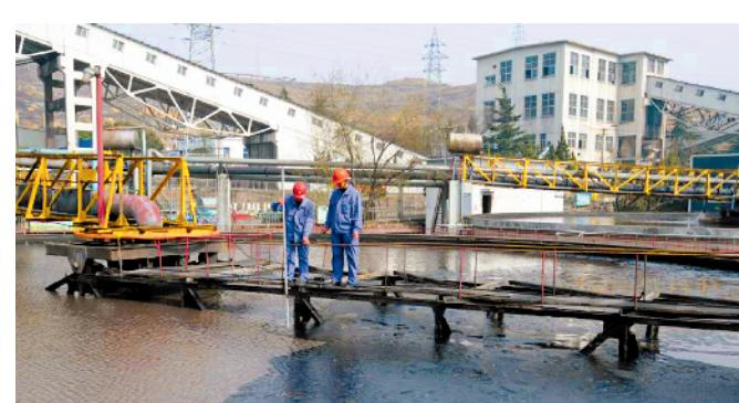
淮北选煤厂将环境保护工作和实施“循环经济”相结合,先后投资 1000 多万元进行技术工艺改造,达到洗水闭路循环国家一级标准,从根本上解决了煤泥水外排污染环境的问题,工业用水重复利用率为 96.05%,实现了污水“零排放”,年节水 40 多万立方米。
