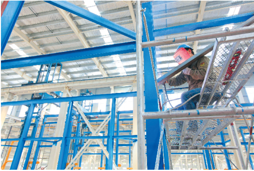
施工人员在焊接行车钢结构。
