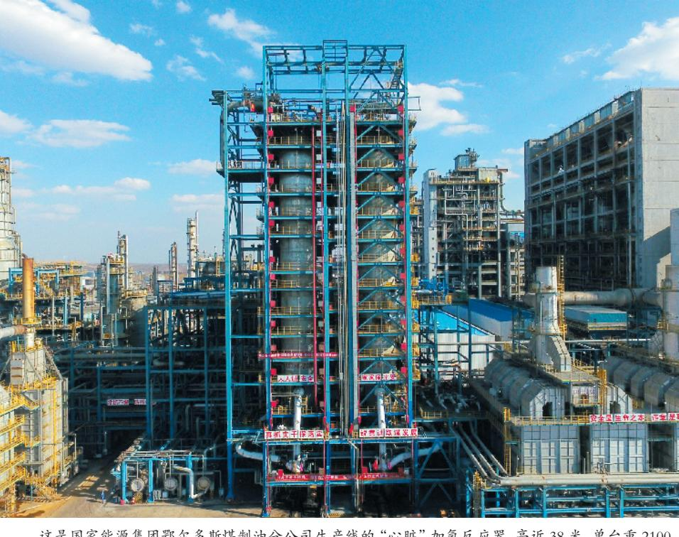
这是国家能源集团鄂尔多斯煤制油分公司生产线的“心脏”加氢反应器,高近38米,单台重2100多吨,体量居全球在役加氢反应器之首(4月11日无人机拍摄)。 ■摄影 新华社记者 刘磊
